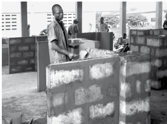
Une formation solide fait partie intégrante de bonnes conditions de travail. Apprentis maçons lors d'un cours organisé par le syndicat. Photo: FTBC
